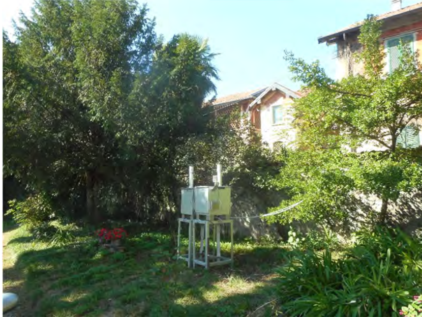
Fig. 2 Postazione di monitoraggio C (Loc. Santa Marta, Comune di Ternate)
